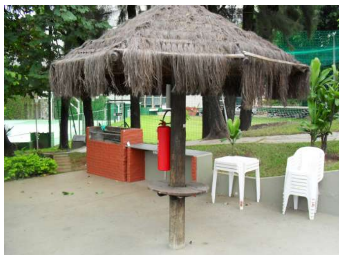
Quiosque 2, antes da reforma realizada em 2020.
