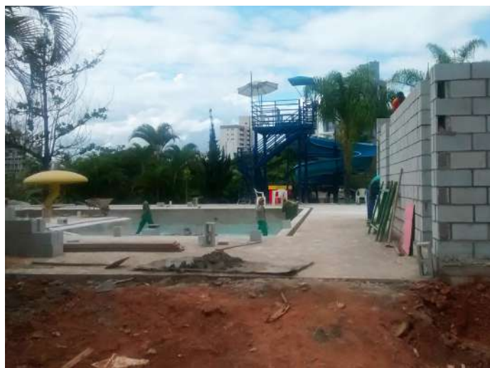
Construção da piscina e vestiários infantis.
