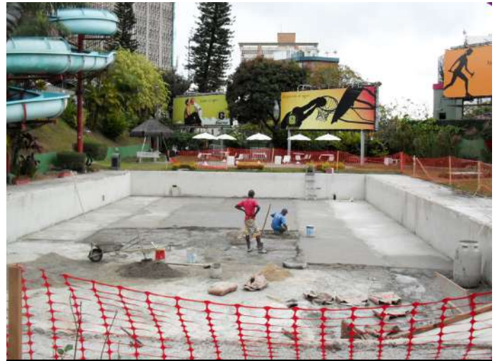
Reforma da piscina semiolímpica.
