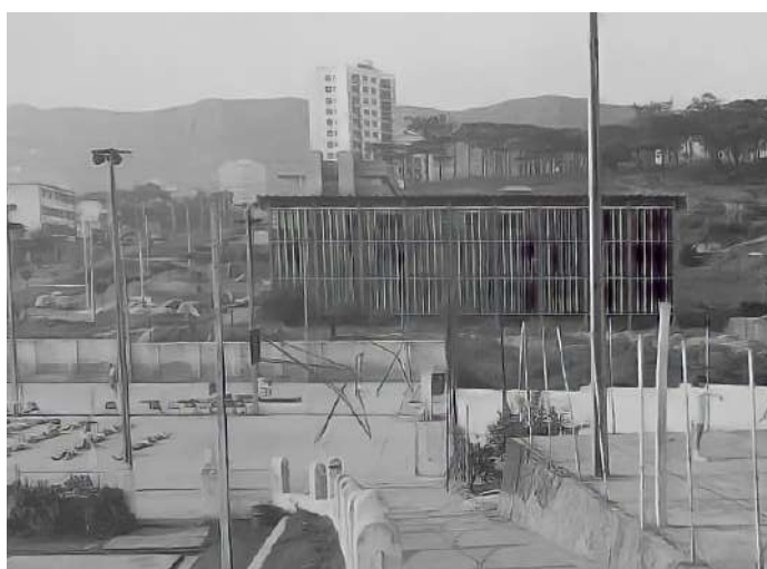
Vista das dependências do clube, nos anos 1950.
