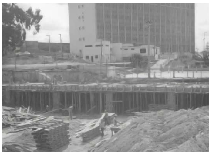
Construção da sede social na Av. Afonso Pena.
